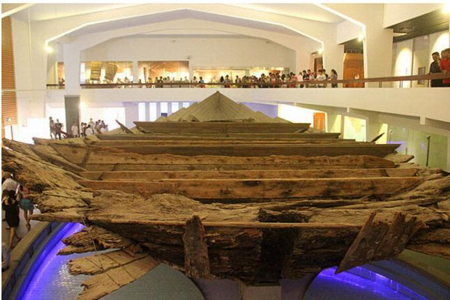
泉州海外交通史博物馆中陈列的宋代古船。这是一艘远洋贸易船。可以清楚地看到用水密舱壁区隔划出的水密隔舱，这是一种用来防止进水的安全结构设计。
